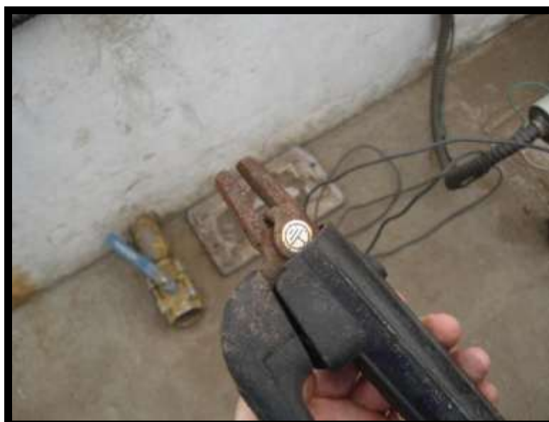
Figura 18 – Vista da garra de aterramento oxidada.
