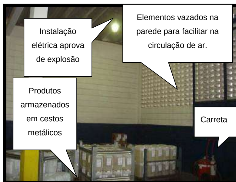
Figura 14 – Vista interna do depósito de inflamáveis. Fonte: Arquivo pessoal
