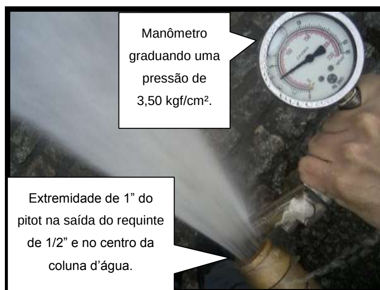
Figura 6 - Teste de pressão sendo realizado através do tubo pitot Fonte: Arquivo pessoal
