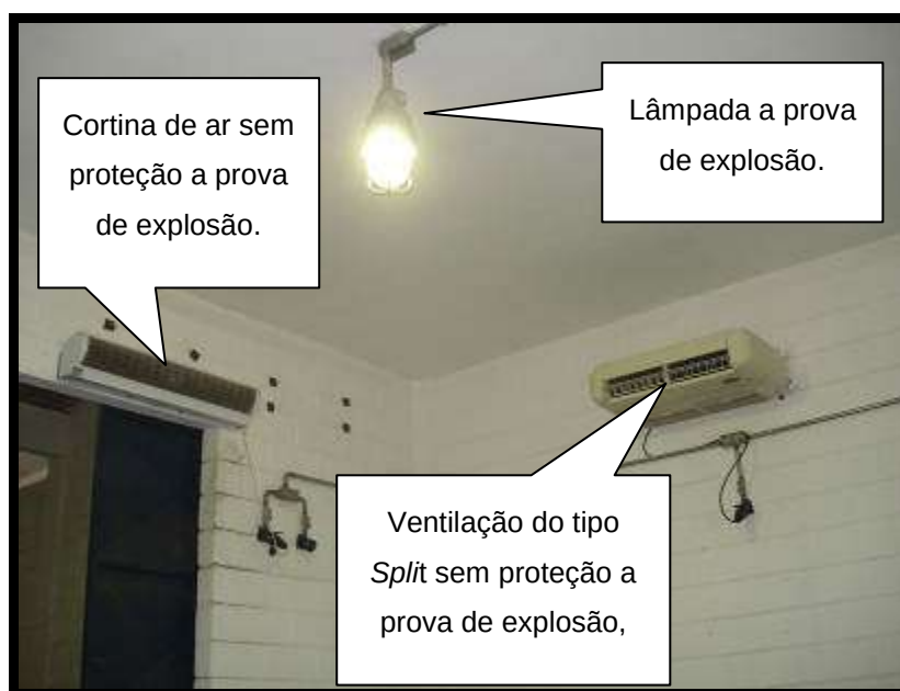
Figura 16 - Vista interna da sala para depósito de álcool. Fonte: Arquivo pessoal
