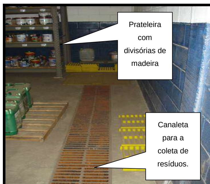
Figura 15 – Vista interna do depósito de inflamáveis. Fonte: Arquivo pessoal
