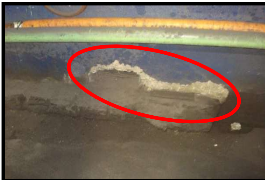
Figura 30 - Orifício feito na parede compartilhada com o porão da bobina. Fonte: Arquivo pessoal
